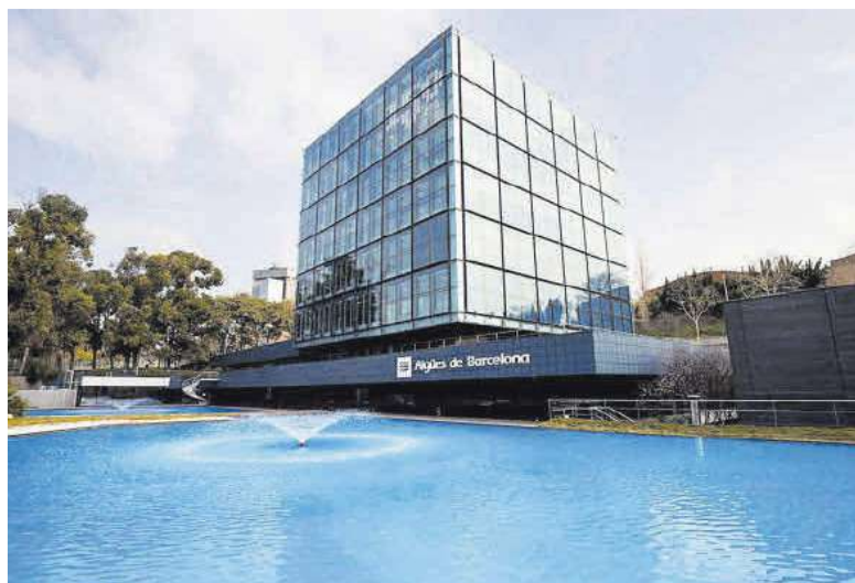
Panorámica de la sede de Aigües de Barcelona.
