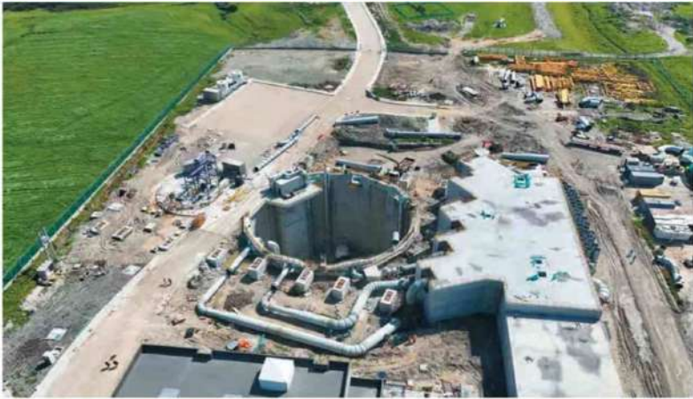
La estación elevadora se entregaría en diciembre de este año. / Acueducto
